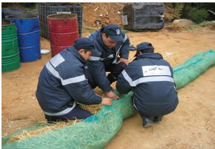
Slika 44. Improvizovane sorbentne brane napravljene od slame i mreže
