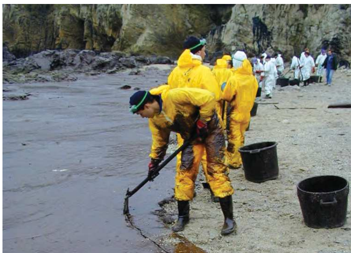
Slika 41. Ručno sakupljanje emulgiranog loživog ulja sa pješčane plaže krupnog pijeska
