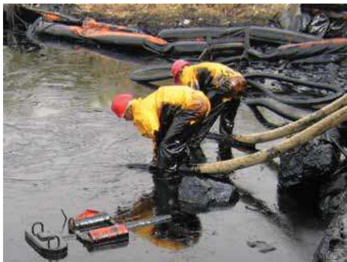
Slika 21. Stavljanje crijeva na vakuum pumpu direktno u ulje
