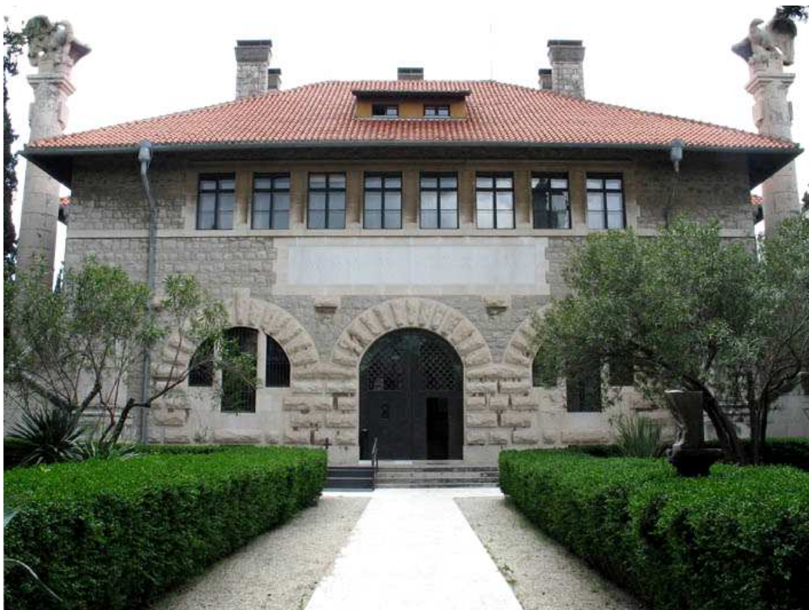
Slika 29: Zgrada Arheološkog muzeja u Splitu 90
