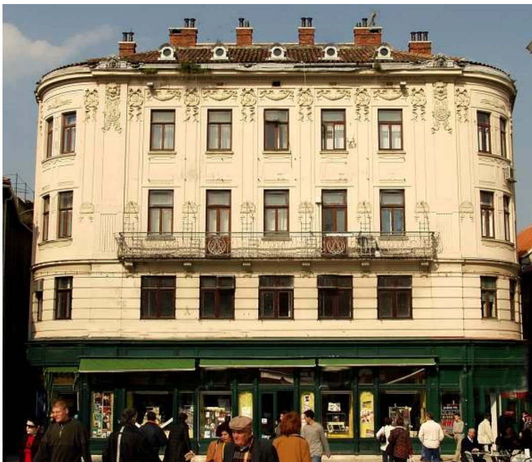
Slika 17: Kuća Vicka Nakića, djelo Špira Nakića 67
