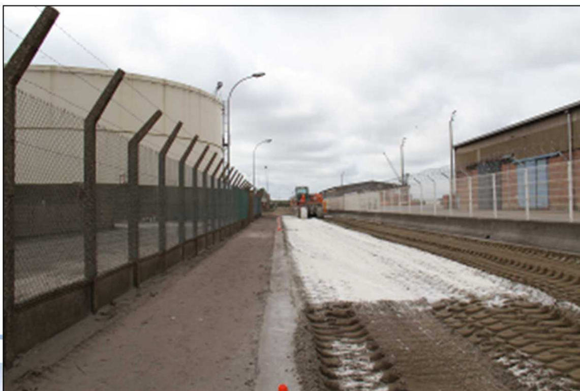
Slika 5. Luka Dunkirk, Francuska - korišćenje iskopanog sedimenta za asfaltnu bazu 84
